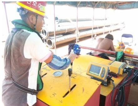
바지선의 작업 위치와 방향에 관한 데이터가 한눈에 알아보기 쉽게 표시 됨으로써 작업 상황을 쉽게 이해하고 확인 할 수 있습니다. 현장 작업자와 관리자 모두 바지선의 이동 경로까지 표시되며 GPS를 이용해 현 위치의 좌표도 확인 가능 하다면 별도의 측량선이 필요 없고 작업 진행 과정까지 한번에 확인 할 수 있다며 모니터 조작도 쉬워 업무에 큰 도움이 되고 있다고 합니다.
