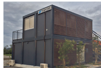
福岡県 北九州トレーニングセンタ 福岡県北九州市若松区 ひびきの北 4 番 1 号
