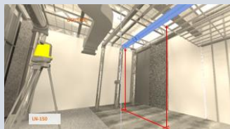
⑪ 設備の墨出し
