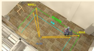
① 地縄張り
