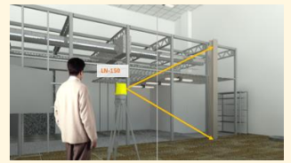
⑦ 建入れ精度確認
