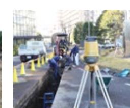
都市部での下水工事
