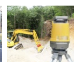
山間部での掘削
