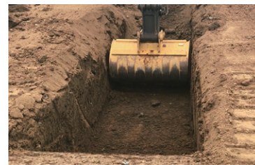
設計データに沿って掘削
