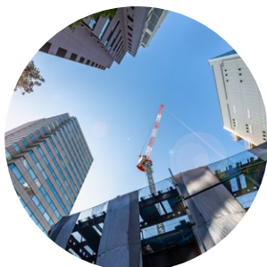
上空視界の狭い 都市部工事
