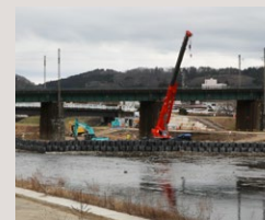
河川 (法面整形)
