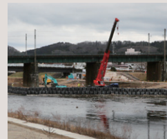
河川 (法面整形)
