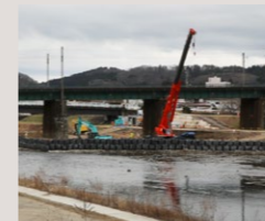
河川 (法面整形)
