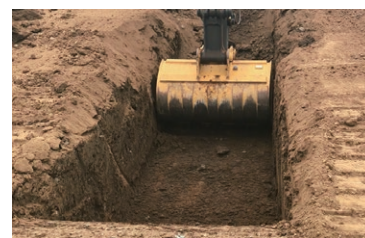
設計データに沿って掘削
