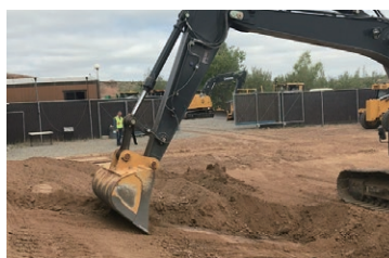
法面も設計データ通りに簡単に整形
