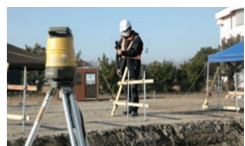
丁張 丁張設置の切り出し位置へ素早く誘導！
