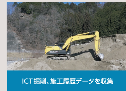
長野県松川ダム 貯水池内掘削工
