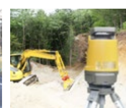
山間部での掘削
