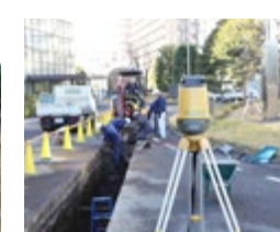
都市部での下水工事
