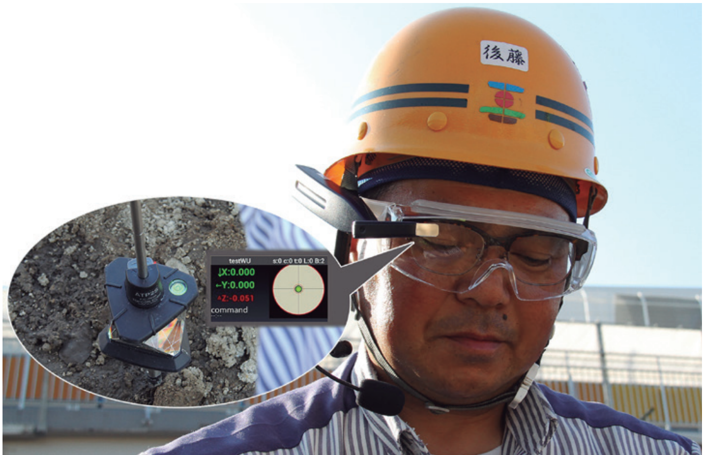
墨出しナビゲーションの使用イメージ。スマートグラスの画面は、視界のごく一部に表示される。ハンズフリーでありながら、周囲の状況を把握しつつ作業が行える。
